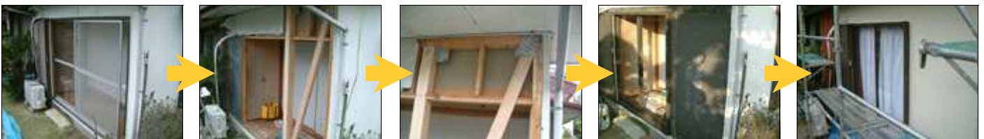
9尺(2.7m)のサッシを6尺(1.8m)に交換する
