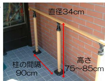
玄関アプローチの屋外手すりは、気温によって表面温度の変化が少なく、握り心地の良い防汚性能が優れた手すりを選択した。埋め込み式と異なり、アンカーで固定したため、床のタイルの損傷を最小限に止めることができた。
