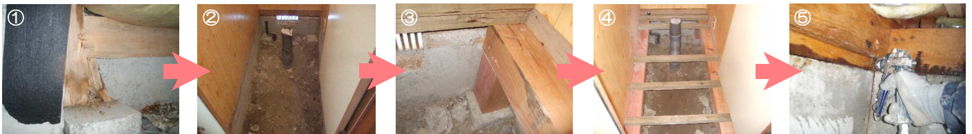
①②シロアリの被害が判明した土台や束や根太を取り除き、③④新しい土台と束、根太を施工し、⑤薬剤を木部に注入した。
