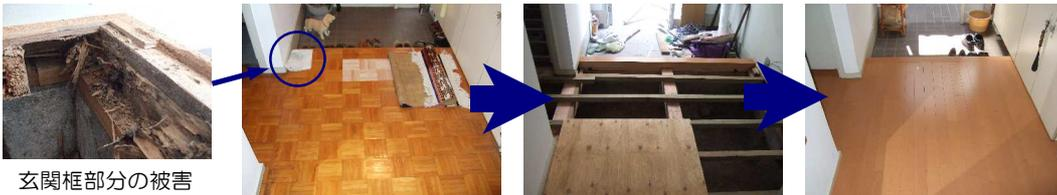
(施工例) 被害のあった大引・根太・合板をすべて撤去し、湿度を調整するシート・大引・根太を施工し、薬剤を散布したあと、フローリングを施工した。
