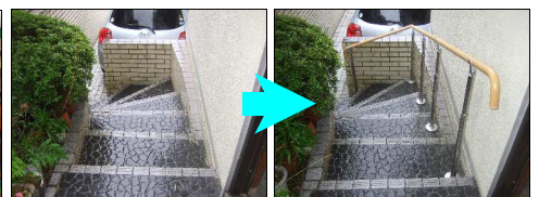
支柱の間隔は90cm以下、手すりは温かみのある素材で連続性を保ち、端部はカーブで仕上げた
