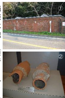
（写真①）横須賀市水道局走水水源煉瓦造貯水池 （写真②）土管（アスンパイプ）
