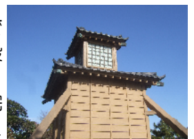
観音崎灯台（上）と復元された燈明堂（下）
