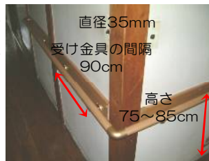
廊下の施工例
