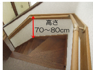
階段の施工例
