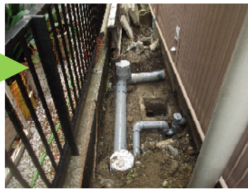
3日間かけて、6ヶ所あるコンクリートの排水マスをビニールの排水マスに交換した。
