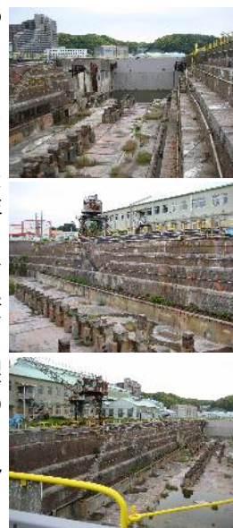
浦賀ドック （明治32年建造） 長さ180m幅20m深さ11m
