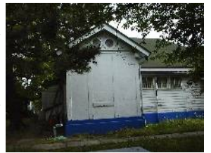
解体される前の ティボディエ副首長官舎
