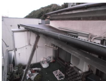
4人がかりで屋根を解体しました
