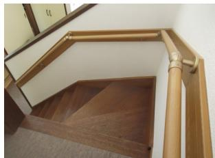
階段は、手をスライドさせながら昇り降りができるように、連続した手すりを設置します。
