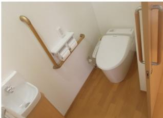
トイレは、車イスでもアプローチがしやすくなるように、スライドドアで段差をなくし、自動で点滅する照明を設置します。
