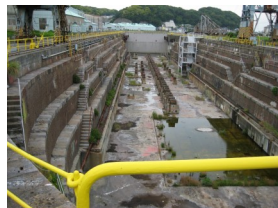
浦賀ドックは榎本武揚等により中島三郎助を偲び建設されたものです
