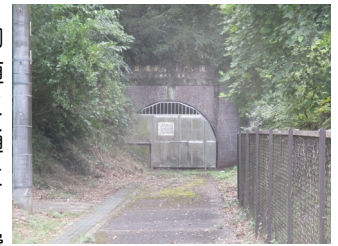
田浦配水池付近の盛福寺管路隧道
